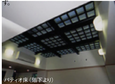
パティオ床(階下より)
