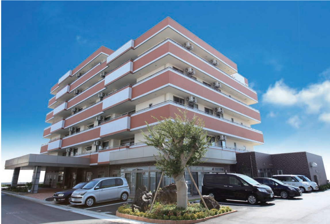
特別養護老人ホーム オレンジタウン笠寺 (平成28年1月竣工) 名古屋市南区 S造/6F 延べ床面積/4286.75㎡
