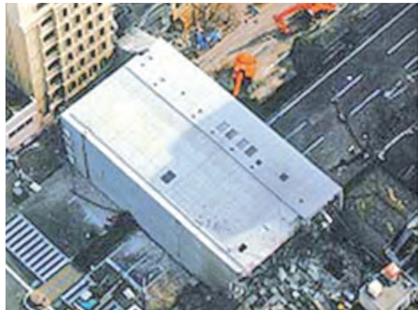
阪神・淡路大震災で倒壊した建築物(出展:国土交通省)
