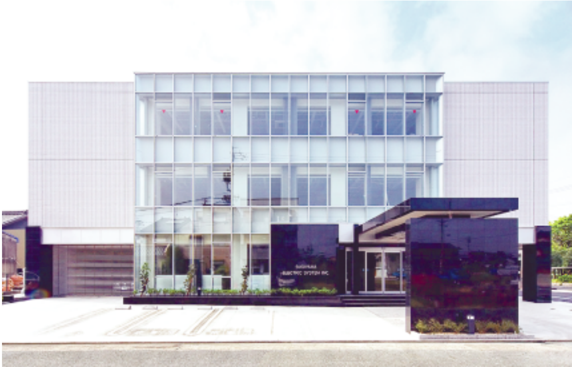
杉山電機システム(株) 本社社屋(平成21年4月竣工) 名古屋市中川区/RC造 4階 延べ面積1,361.62㎡
