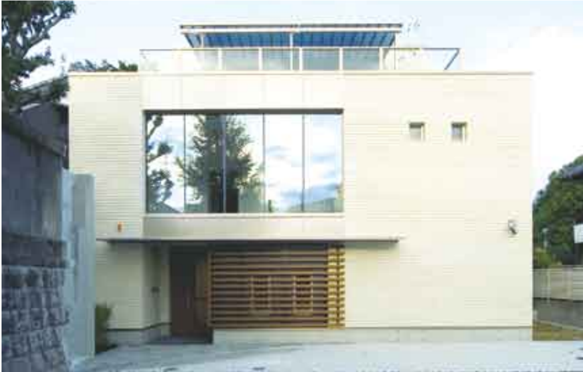
S邸（外断熱住宅）（平成19年12月竣工） 名古屋市昭和区／RC造 B1階・2階 延べ270.71㎡
