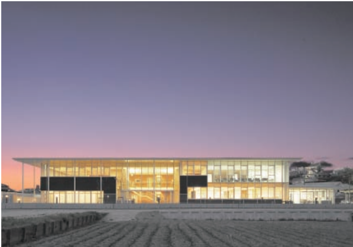
日進市立北部福祉会館(平成19年3月竣工) 日進市岩崎町/RC造2階 延1,622㎡
